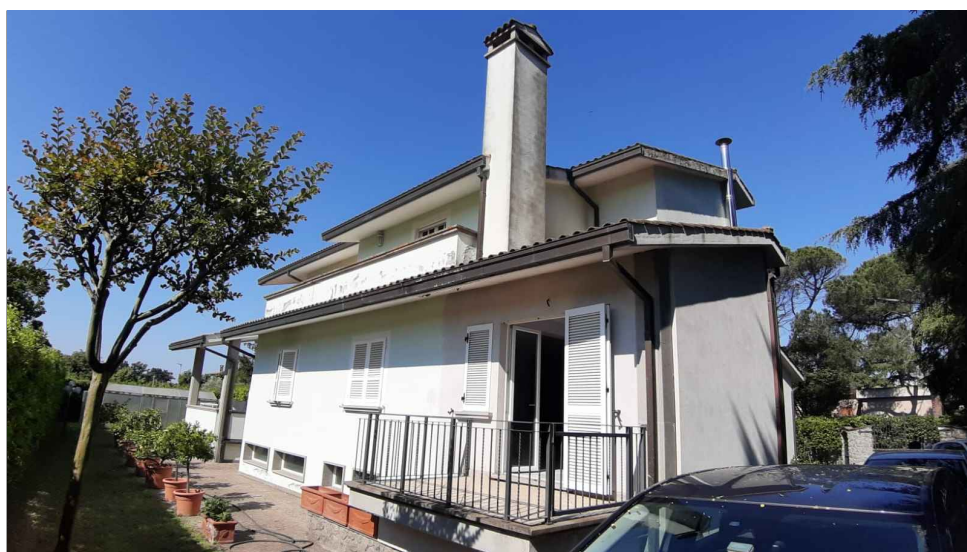
foto 4 - vista esterna da nord-est.
