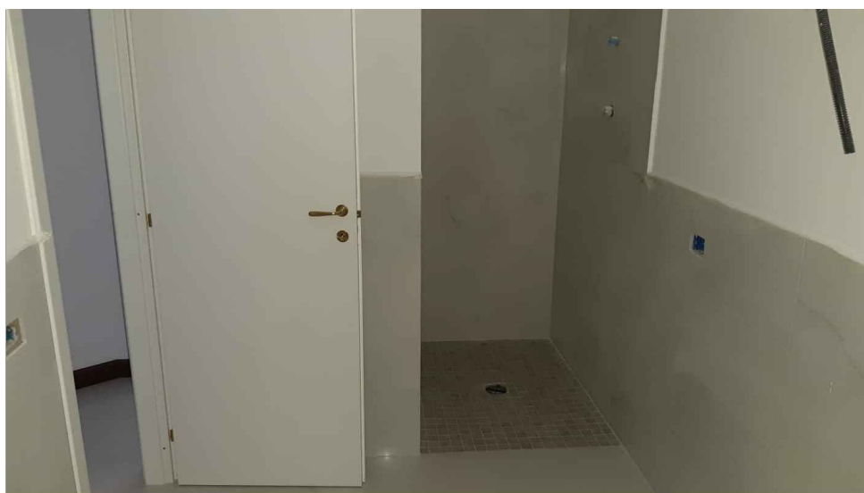
foto 14 - vista del bagno n. 2.
