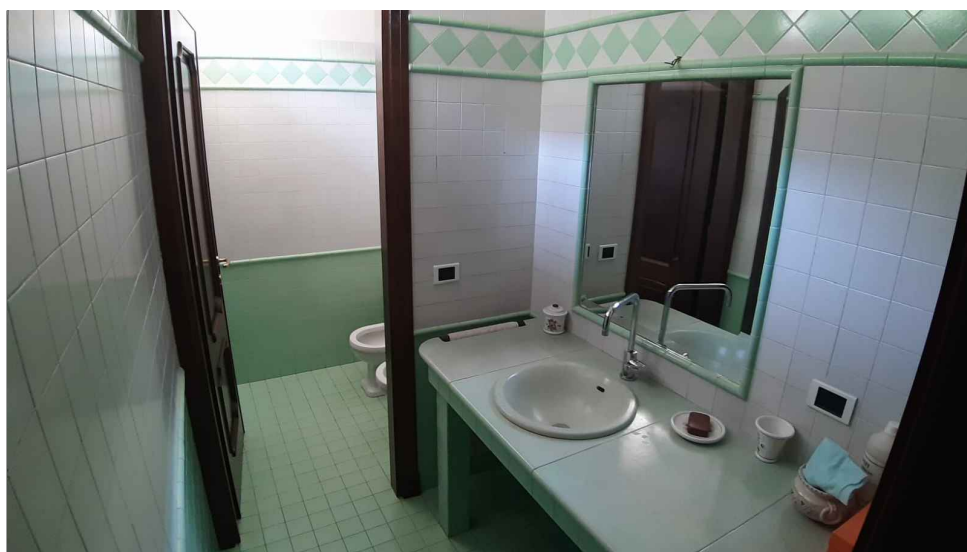
foto 32 - vista del bagno al piano seminterrato.
